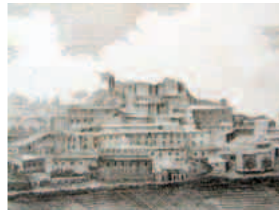
Monteleone Il Castello federiciano dopo il terremoto del 1783
